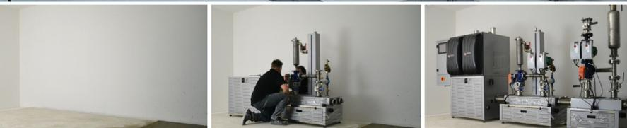
Chaufferie : 2 chaudières de 125 kW, 1 circuit de chauffage, 1 production ECS, 1 armoire électrique et régulation, module de filtration/admission
